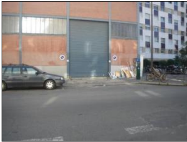
Photo 1 : Entrée rue Lecourbe, inondable : rampe d'accès à l'atelier
